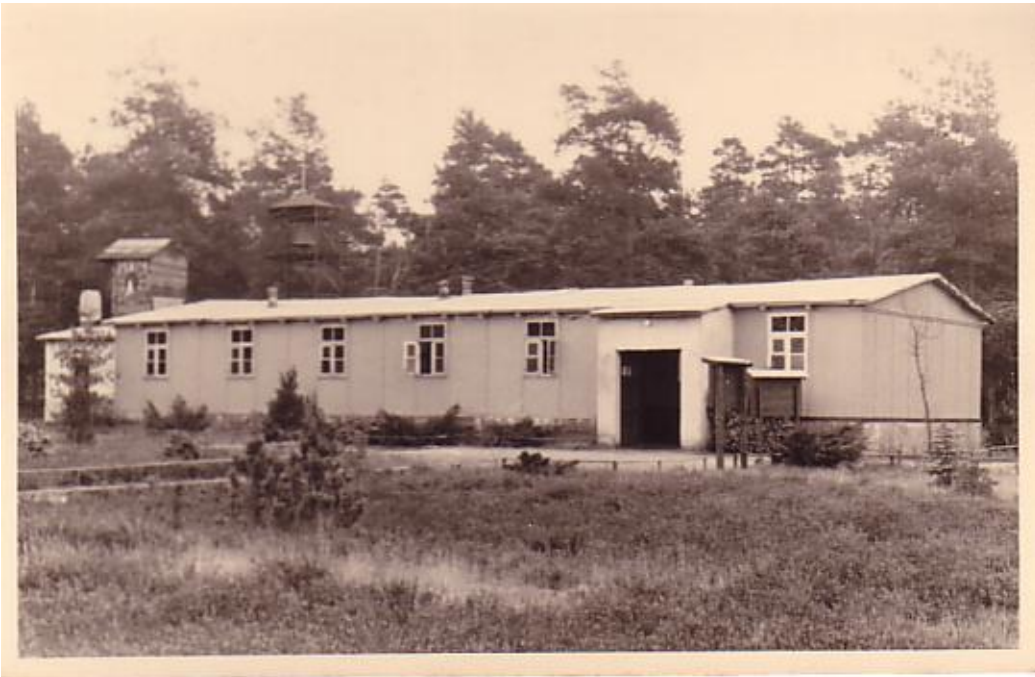
Abb. 15: Die Behelfskirche auf Sinnenheide, nach dem 24. Mai 1948. Von diesem Tag an lief die Uhr in dem Holztürmchen, das auf den Sakristei - Anbau gesetzt worden war. Ein Jahr vorher war der "Glockenturm" fertiggestellt worden; seine Glocke rief die Mastbrucher bis 1957 zur Messe.
