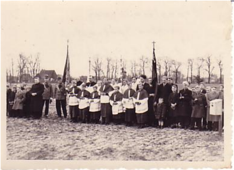
Abb. 19: Schützen und Messdiener sind angetreten, ganz Mastbruch hat sich für den großen Tag fein gemacht. Die Landschaft im Hintergrund sieht trostlos aus, aber an diesem 23. März 1952 beginnt mit dem ersten Spatenstich der Kirchenbau.
